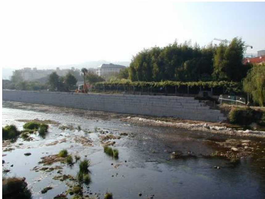
Obras na canle
